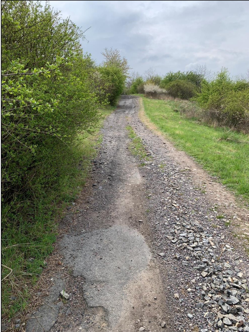
Obr. 27: Stávající hlavní příjezdová komunikace, která bude dle projektu upravena a zpevněna.
